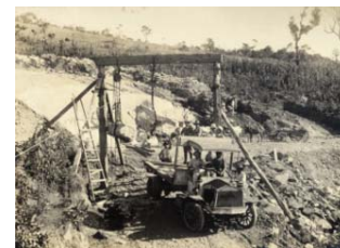
Construção do hospital.
