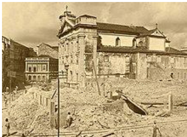
Trabalhos de demolição do Largo e Igreja do Corpo Santo, 1913.
